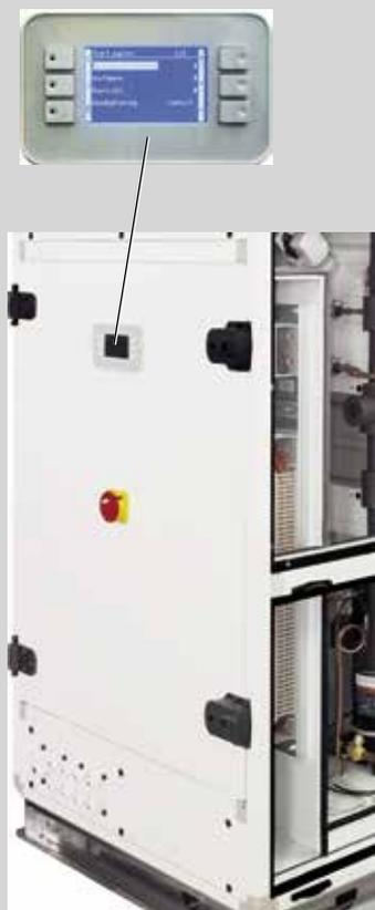
La regulación controlada por microprocesadores, montada y cableada de fábrica con interruptor integrado en el equipo, controla y regula ventiladores, compresor, recuperación de calor, temperaturas, caudales volumétricos, tiempos de funcionamiento y numerosas funciones internas y de alarma.
